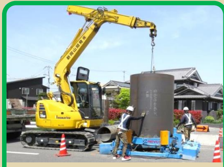
下水道工事では、立坑(たてこう)を掘り、その穴の中に降りて作業をします。 この大きな筒が地面に埋っていきんですよ!
