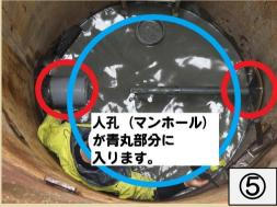
①②家と家の間、ぎりぎりの幅での作業です。③完成した縦穴がこちら。深い…④縦穴の底に機械を設置し、矢印の方向に機械で管を推し差していきます。下水道管は傾斜をつけて設置しています。⑤二つの赤丸部、地中を通った管が出てきました。青丸部分には点検用のマンホールが入ります。
