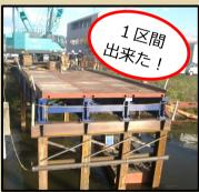
先月末より本格的に工事がスタートしていて、現在は取り壊す歩道部分の隣へ仮設の橋を設置しています。 川の中に橋脚となる鋼材を打ち込んだ後、橋脚同士をつなげて支える役目の橋桁(はしげた・写真の青い部材)を横に架け渡します。最後に、床となる覆工板(ふっこうばん)を敷いていきます。この作業を繰り返して仮設橋を川の向こう岸まで伸ばしていきます。仮設橋が出来たら、そこを作業スペースとして向こう岸から橋の歩道部分を撤去していきます。
