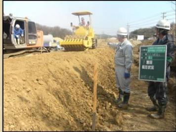
工事前に行う試験で、必要な強さの盛土<sup>もりど</sup>にする為に、指定された転圧回数で良いかを調べる「試験盛土」です。
