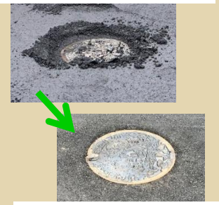
転圧完了。マンホールと同じ高さまで締固められました。
