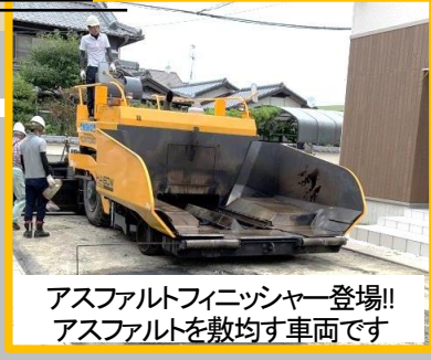
フィニッシャーにアスファルトを投入
