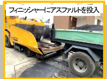
アスファルトフィニッシャー登場!! アスファルトを敷均す車両です
